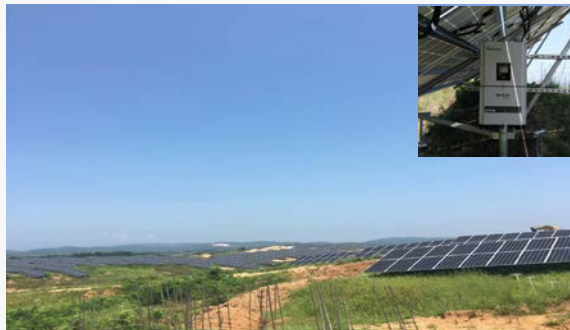
富士康南陽100MW山丘電站
